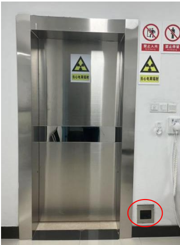
通往控制室的防护小门脚踏 感应开关
