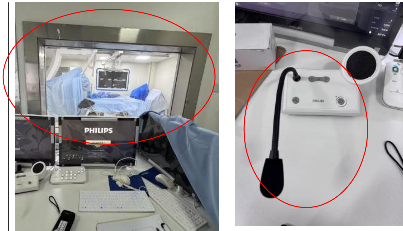
图3-6 本项目DSA机房观察窗及对讲装置
