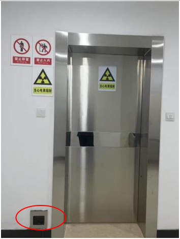
通往污物通道的防护小门 脚踏感应开关
